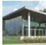
Site Desselgem INSULATION
